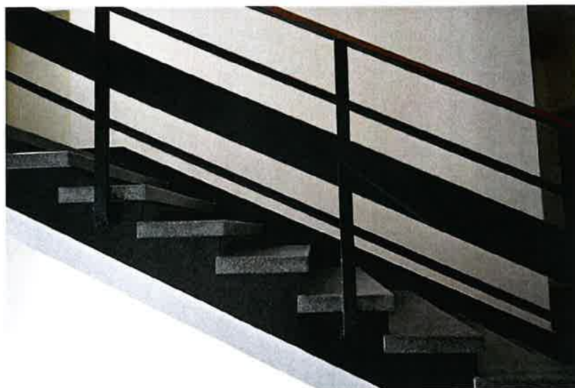
lastrikowe wykończenie spocznika pośredniego
