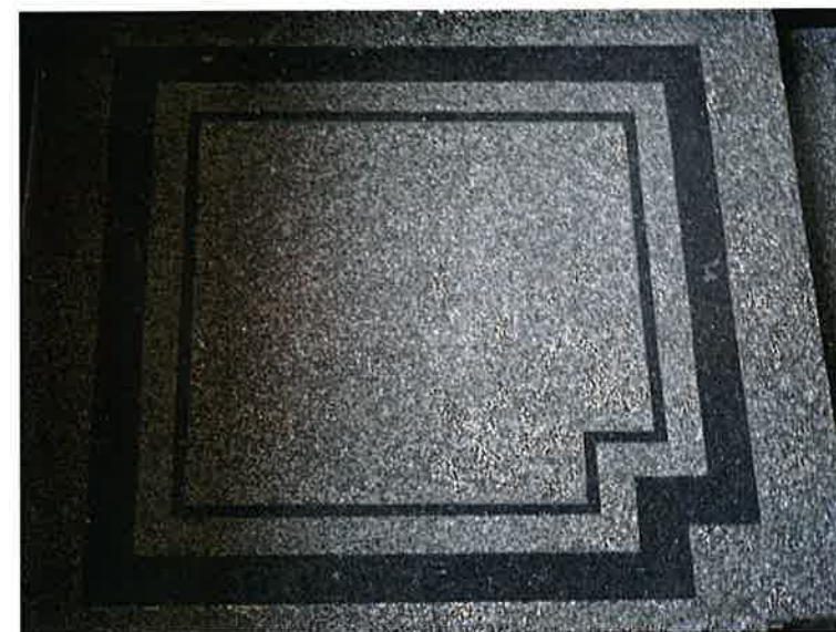
lastrikowe wykończenie spocznika pośredniego
