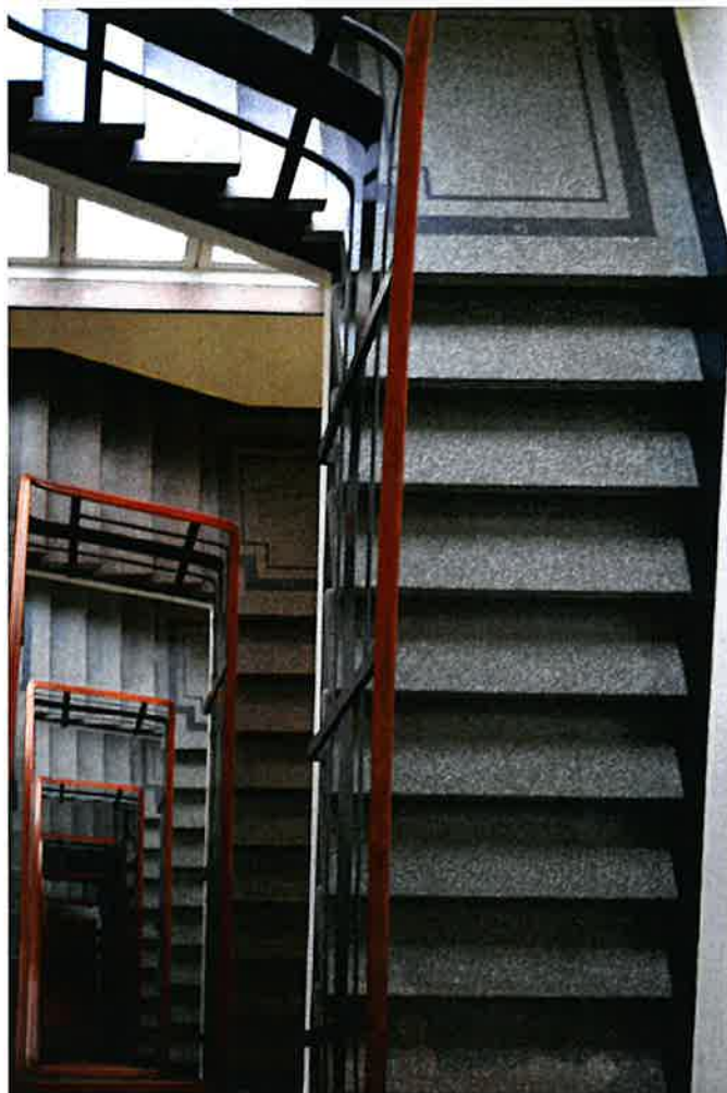
klatka schodowa - schody licowane lastriko ze spocznikami o geometrycznym rysunku
