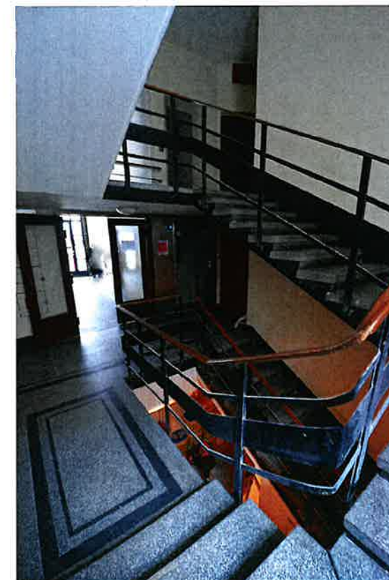
widok ogólny klatki schodowej w poziomie parteru
