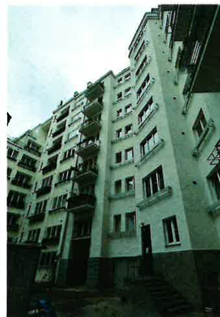
elewacje od podwórza - stan po remoncie
