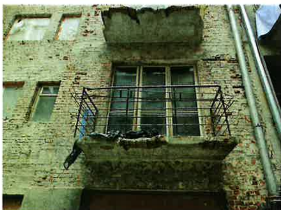
fragment elewacji podwórzowej z balkonem (w trakcie prac remontowych)
