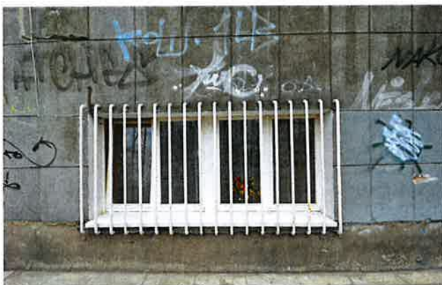
fragment przyziemia z liniowaniem tynku, z oknem suterenu; widoczne wtórne powłoki malaraskie i obrzutka elewacji
