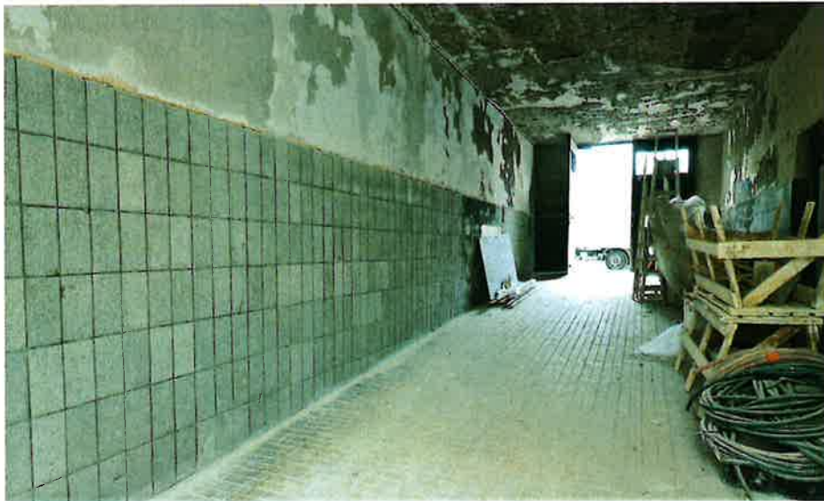
Przejazd bramny przed remontem i w trakcie prac remontowych
